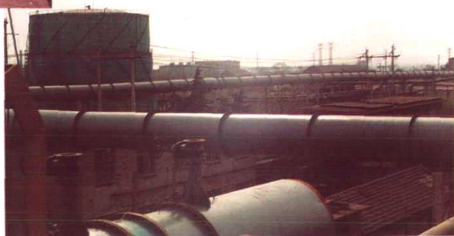
小型连轧煤气管道工程
