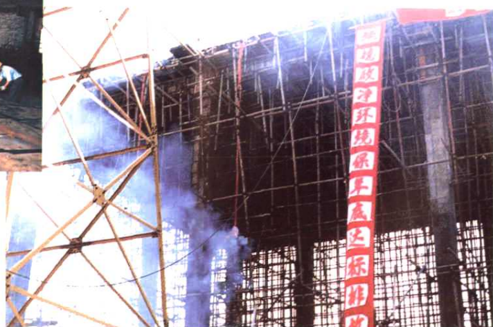
1999年11月，污水处理工程施工现场
