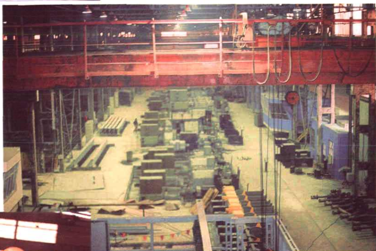
正在安装的小型连轧主线设备
