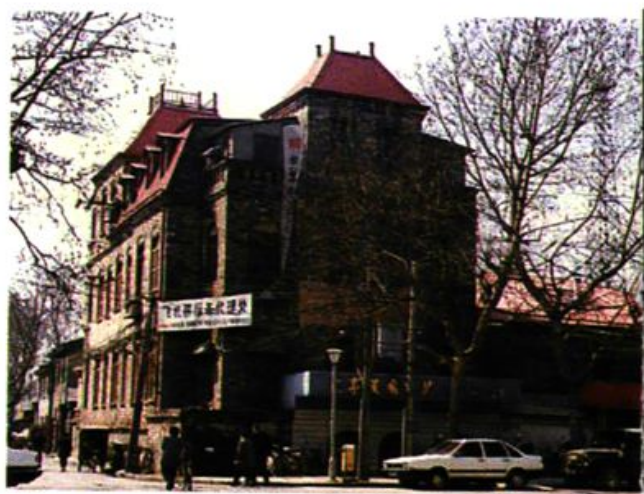
民国时期建筑——扬子饭店 建于 1914 年,现为下关公安分局
