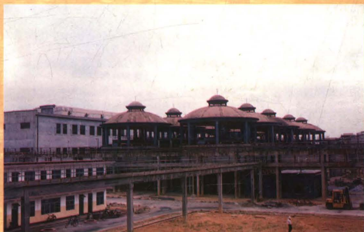
中国工商银行来宾县支行贷款支持的来宾冶炼厂二期工程一角，该项目计划总投资人民币 3.7 亿元。
