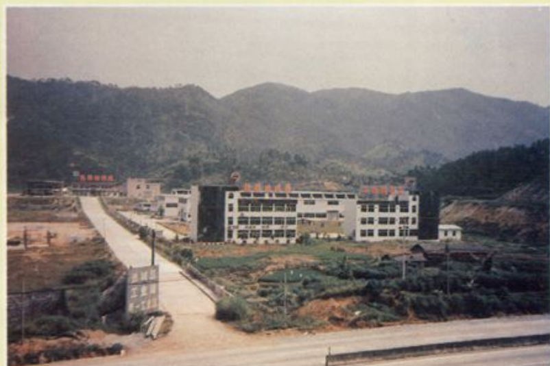
镀膜玻璃厂外景
