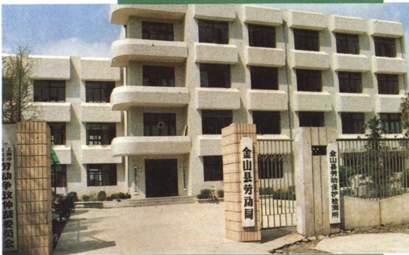
位于朱泾镇人民路275号的县劳动局新址
