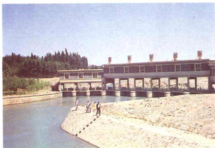
东大河渠首水利工程
