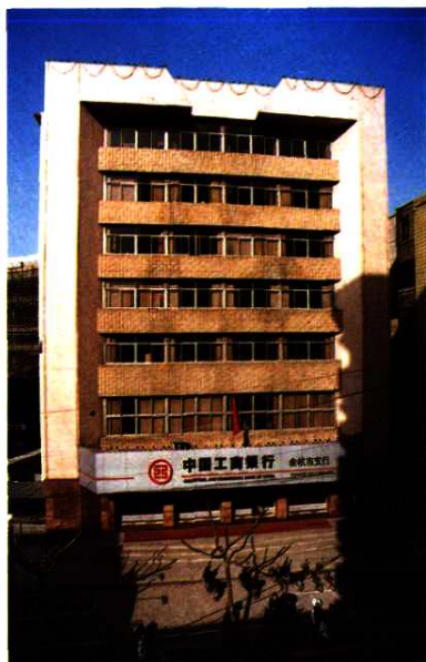
▼ 中国工商银行余杭市支行
