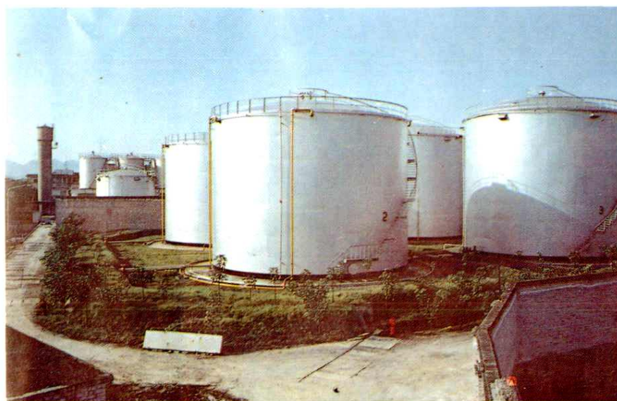
◀ 1990 年江津油库改造扩建后的储油罐区
