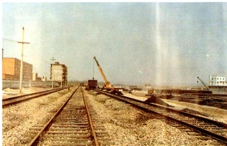
▶ 彭山器材库区内的铁路专用线和料场
