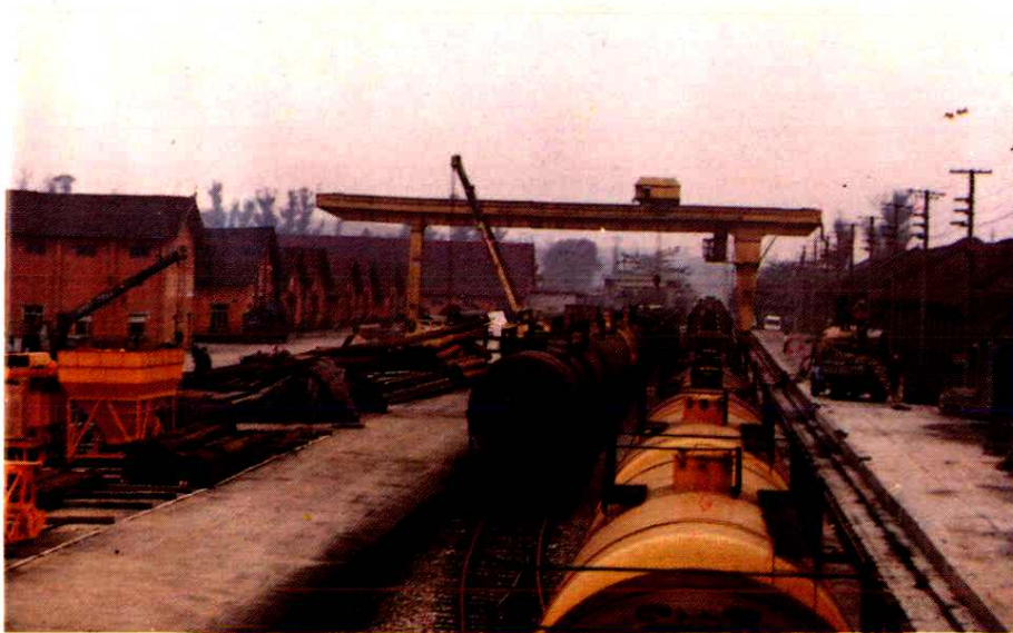
◀ 成都器材库内铁路专用线上的物资调运装卸作业
