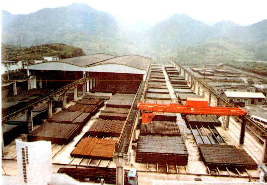
◀ 重庆上桥石油专用管材检测中心
