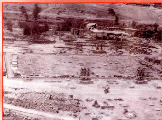
筹建初期土建工程
