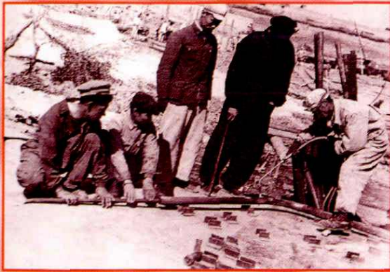
管子工地现场制作
