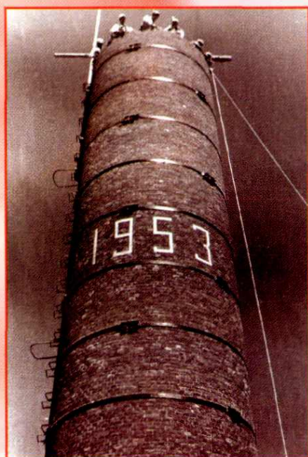
1、2号机组烟囱建筑
