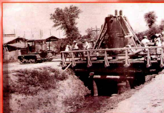
筹建初期搬运设备
