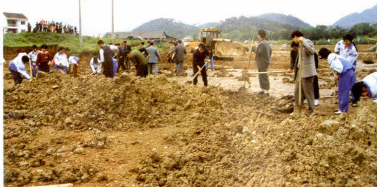
大田镇庙洋村 造田造地现场
