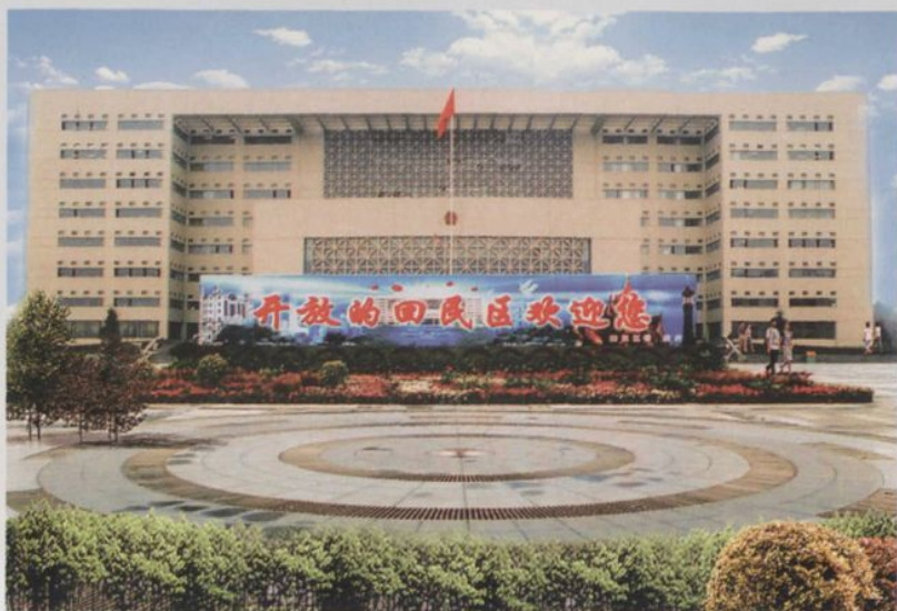
回民区党政办公大楼
