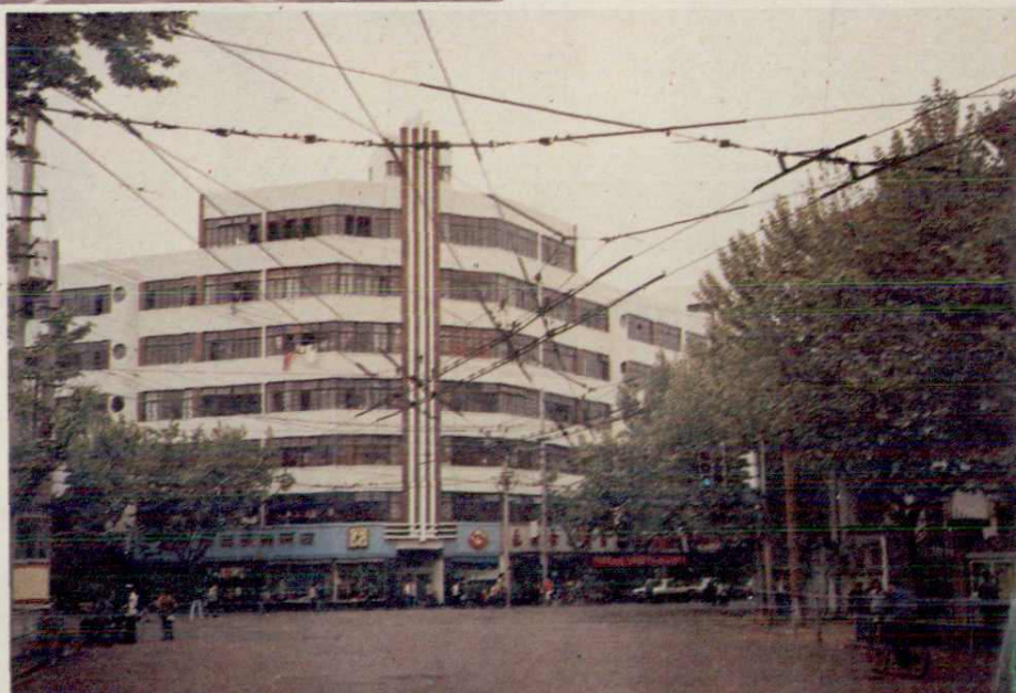
■ 常熟路及淮海大楼
