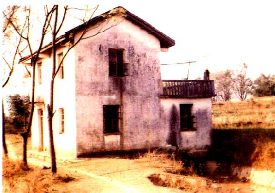
廊田水圳白山管理站
