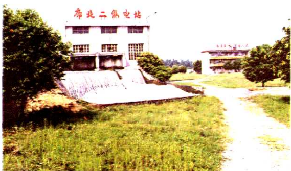
廊北二级电站
