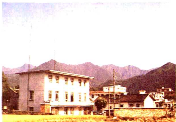
廊北一级电站（廊田电站）
