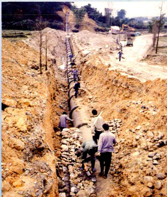
改造中的倒虹吸管工程
