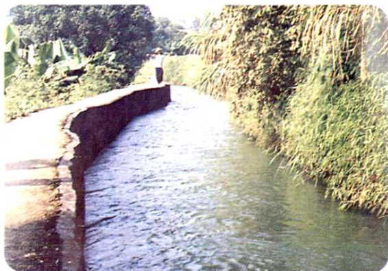
廊田水圳渠道
