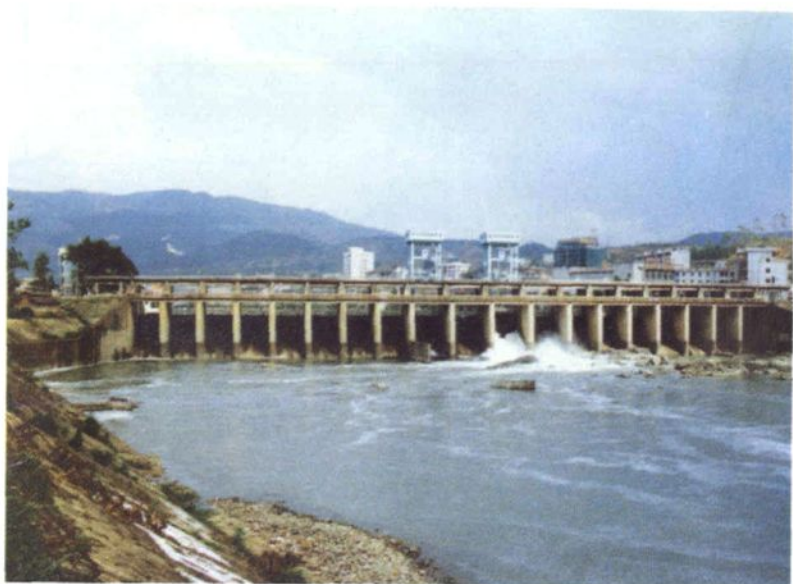
13 华安水力发电厂 装机容量 6 万千瓦
