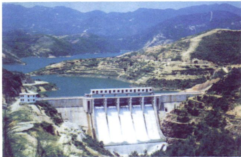
18 诏安岭下溪电 站装机容量 4450 千瓦
