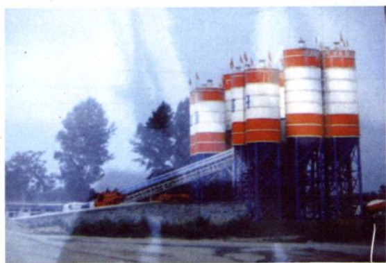
混凝土搅拌厂
