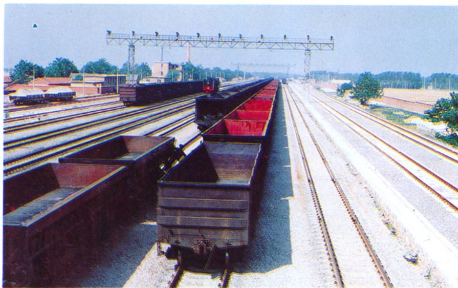
兖州矿区铁路运输中心枢纽大东章集配站
