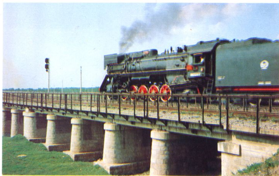
官桥至柴里一号铁路桥
