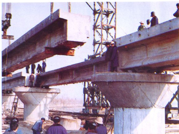
架桥机在铁路大桥施工中
