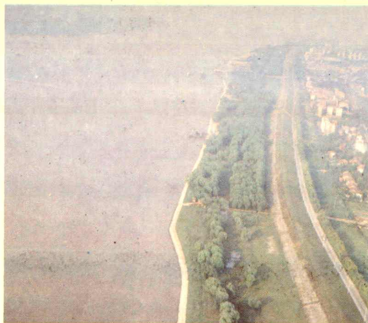
青山堤段，一堤两林，迎水面护坡。堤顶高度，宽度，堤身坡度都达到了规划标准，抗洪能力大大增强。
