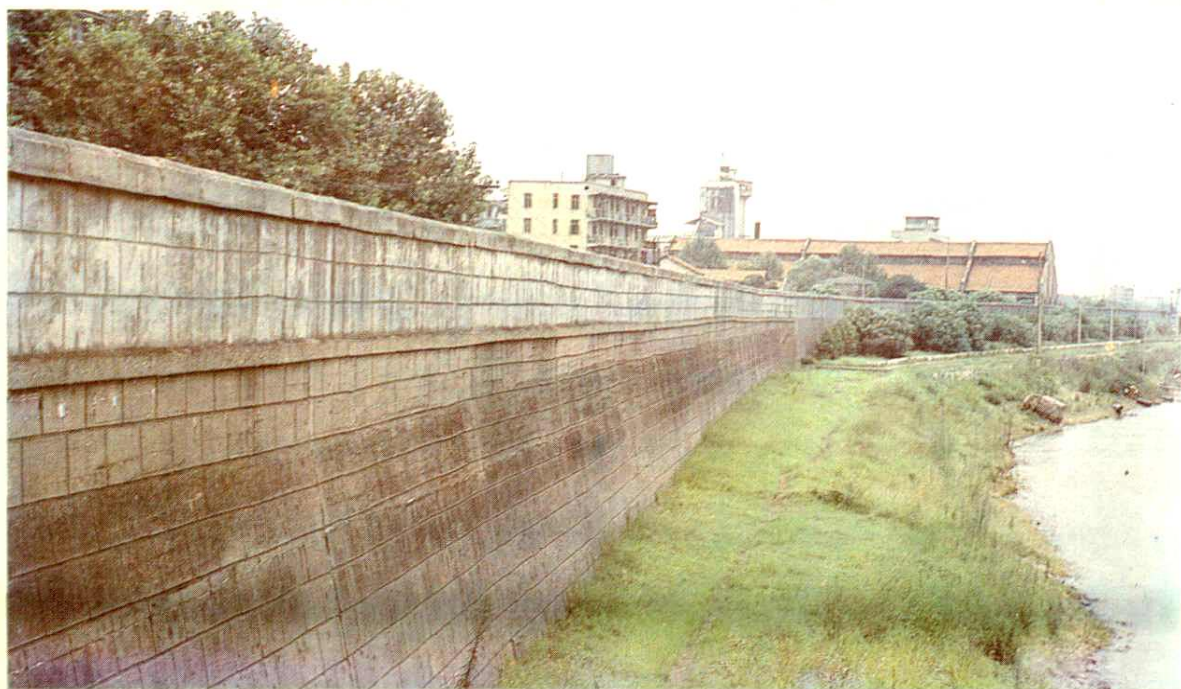
新建防水墙的一部份，它既是防洪大堤的形式之一，又解决了城市土堤占地多的矛盾扩宽了道路。
