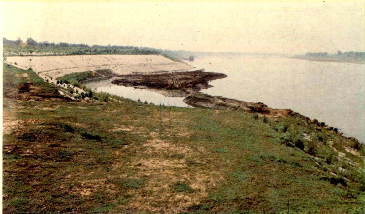
一九八四年十月汉口水口堤段发生严重崩塌险情。退挽复堤工程次年汛前竣工。下图为当时滑坡现场。
