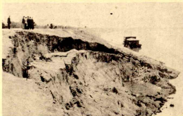
一九八四年十月汉口水口堤段发生严重崩塌险情。退挽复堤工程次年汛前竣工。下图为当时滑坡现场。
