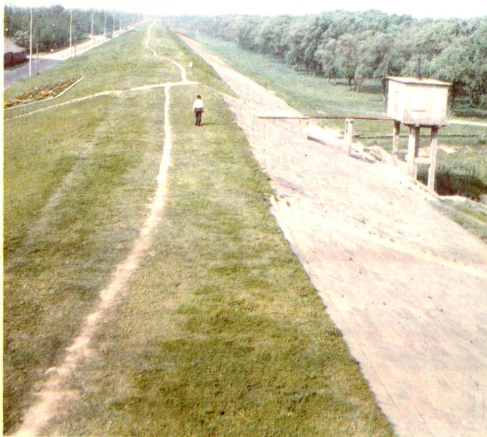
青山堤段，一堤两林，迎水面护坡。堤顶高度，宽度，堤身坡度都达到了规划标准，抗洪能力大大增强。
