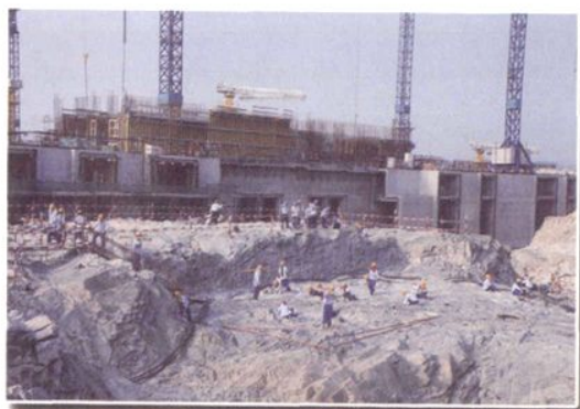
宁德核电施工现场
