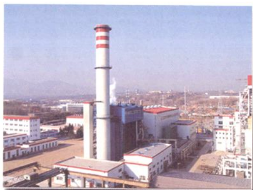
北京京丰350MW燃气蒸汽联合发电工程1号机组
