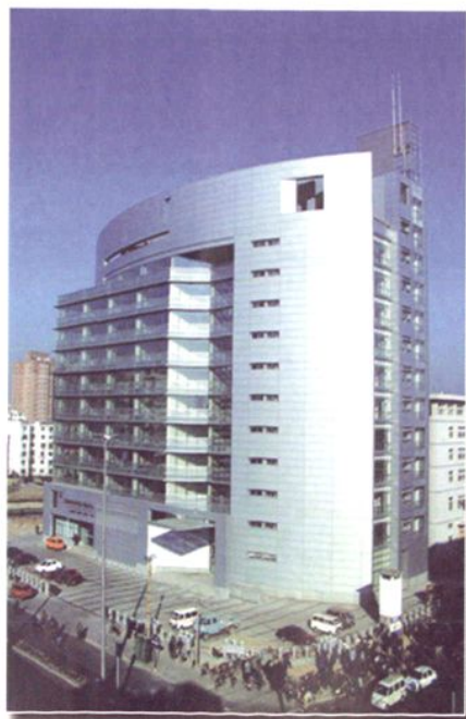
天津电力公司电力科研中心工程
