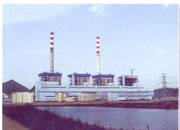
浙江大唐乌沙山电厂一期 4 \times 600\text{MW} 工程(公司承建1号、3号机组) 荣获2008年国家优质工程银质奖, 3号机组成为大唐国际发电装机 容量突破2000万千瓦的标志
