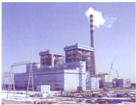
河北大唐王滩电厂一期 2 \times 600\text{MW} 工程(公司承建2号机组) 荣获2007年国家优质工程银质奖
