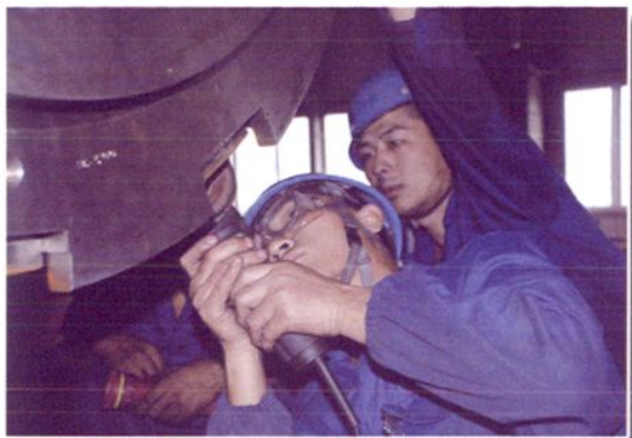
华能上安电厂检修
