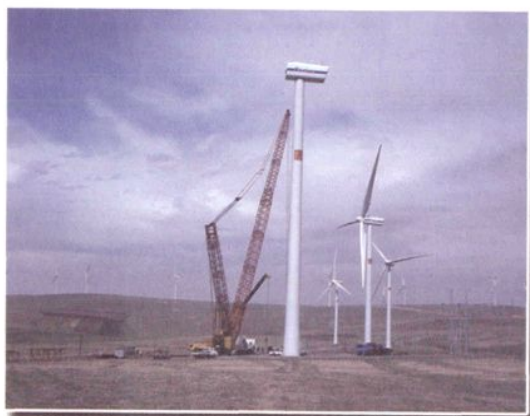
赤峰风电施工现场
