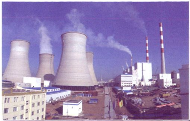
内蒙古国华准格尔电厂二期 2 \times 330\text{MW} 工程 (公司承建1号机组) 荣获2004年国家优质工程银质奖
