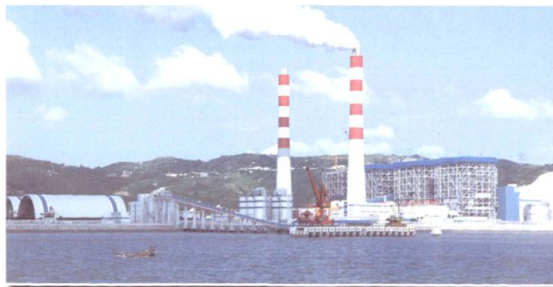
浙江华能玉环电厂为国内首座百万超超临界机组电厂，公司承担了其中两台机组的建设任务，一期 2 \times 1000\text{MW} 工程（公司承建2号机组）荣获2008年国家优质工程金质奖
