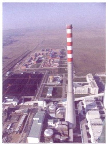
公司参建的内蒙古京能岱海电厂 一期 2 \times 600\text{MW} 工程荣获2007年 国家优质工程银质奖
