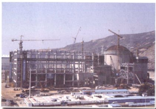
岭澳核电施工现场
