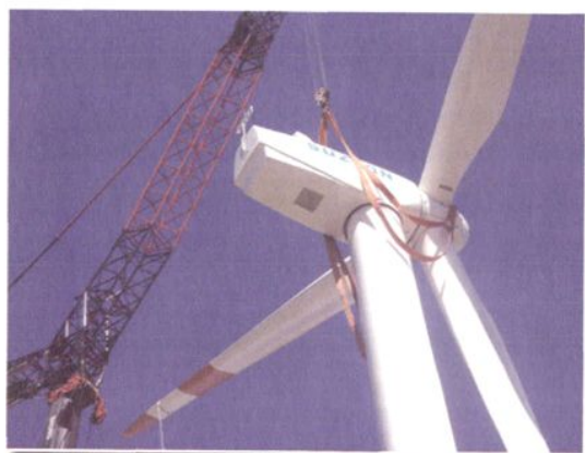
察右中风电施工现场
