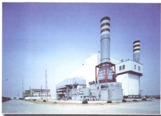
天津滨海电厂燃气—蒸汽发电机组是华北地区第一台联合循环发电机组
