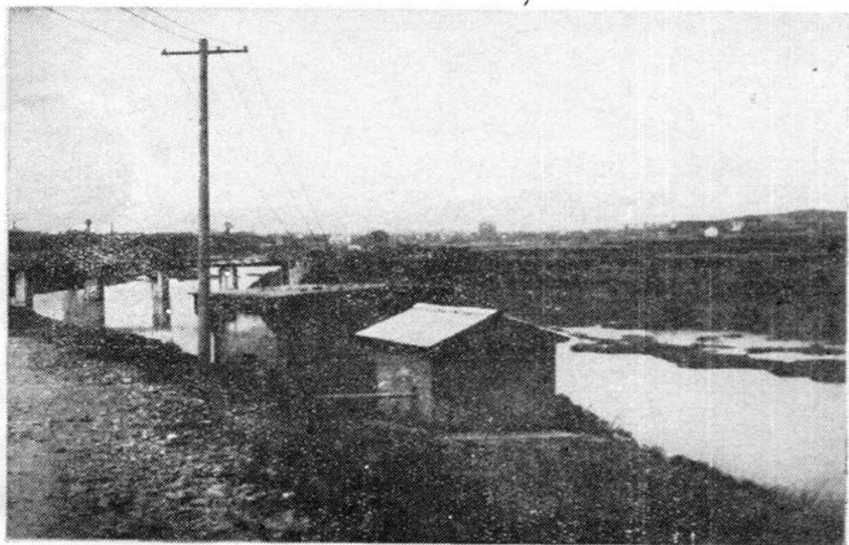
唐家院电灌站机房一角
