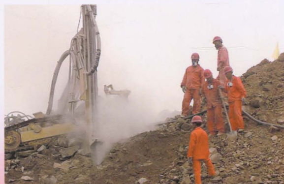
爆破公司施工生产现场
