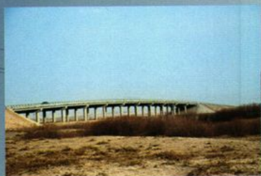
滨洲铁路线立交桥
