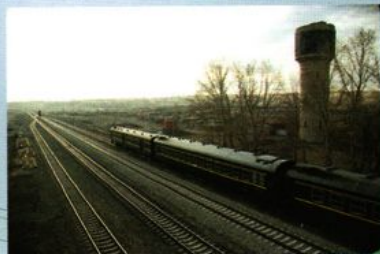
滨洲铁路复线
