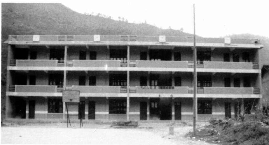
二〇〇六年五河民族小学砖混结构教学楼建成
