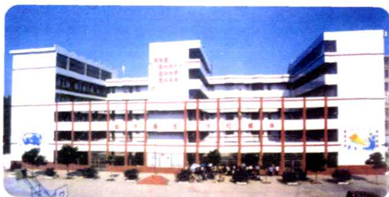
1998年建成并投入使用的“山”字形教学楼
