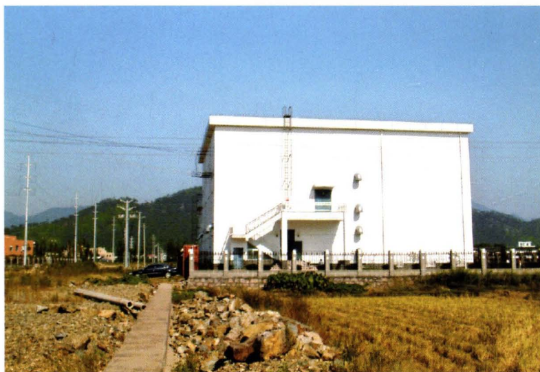
2005 年投产的 110 千伏南湖无人值班 变电所
