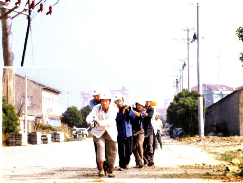
2004 年临海市 城区电网改造工地
