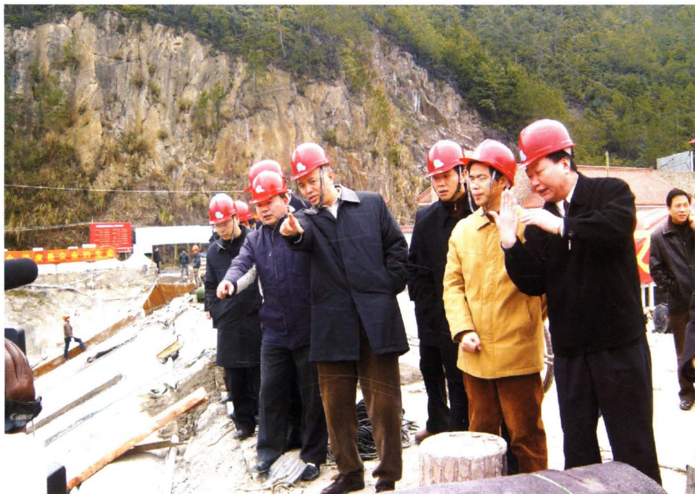
2004年,台州市委书记蔡奇在牛头山水库工地检查大坝维修工程
