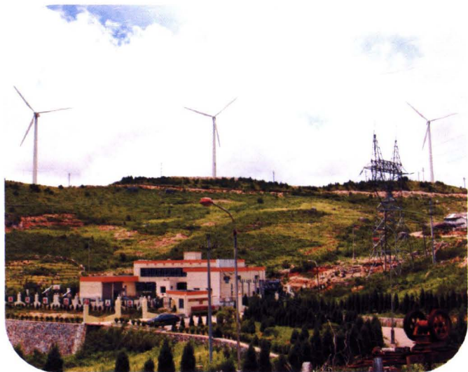
括苍山风力发电场控制室
