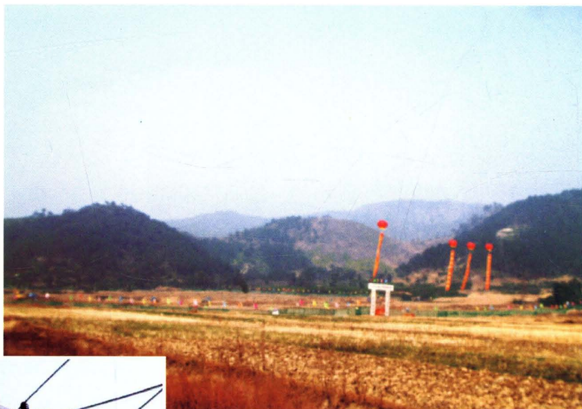
500 千伏临海 变电所基建工地
