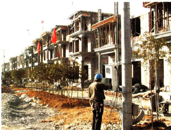
遭受 2004 年 8 月“云娜”强 台风袭击后的推船沟村进行新 村低压电力线路重建
