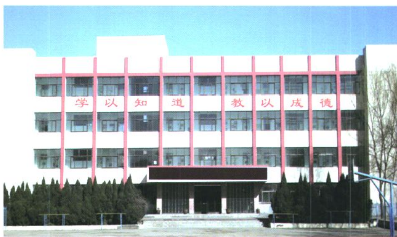
阳泉市郊区河底中学校实验楼
