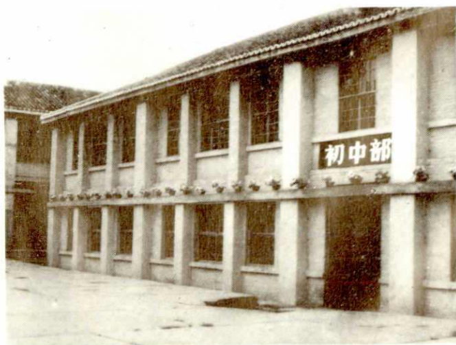
这是加固后的盐源中学教学楼
