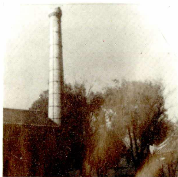
邛海宾馆经过加固水塔
