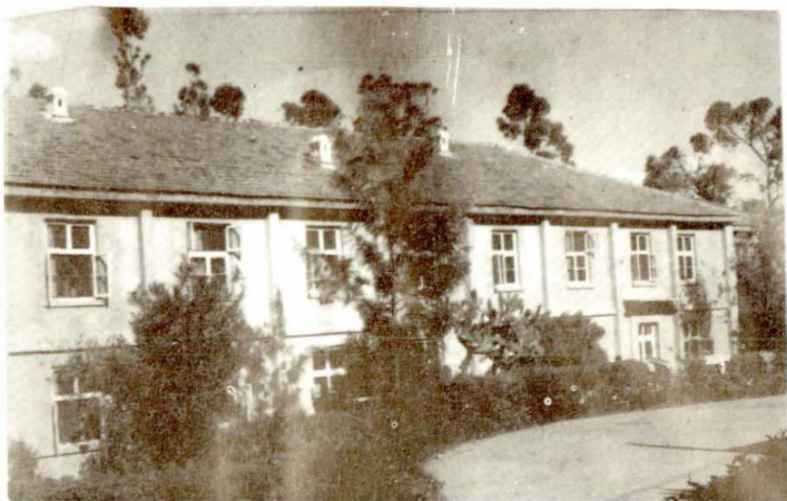
邛海宾馆经过加固楼房
