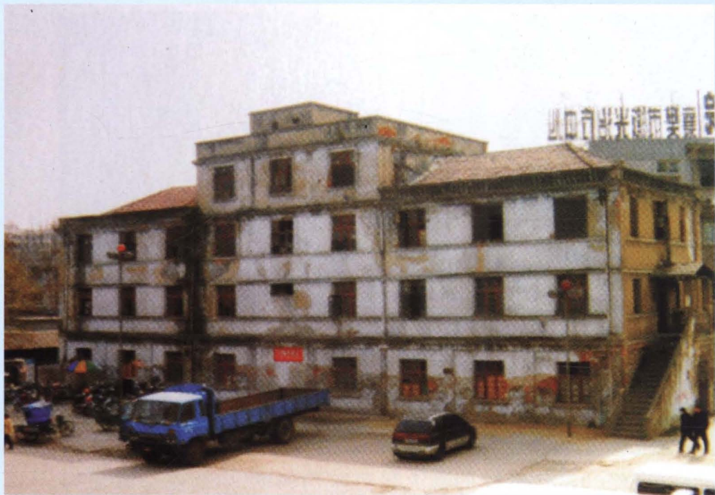
1978年，先期从樊城水星台迁往丹江路的县人民医院综合楼原貌。
