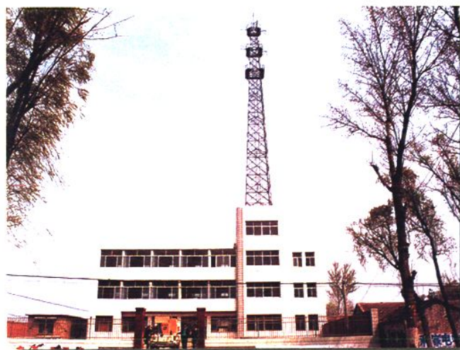
边临镇支局综合通信楼（1998年）
