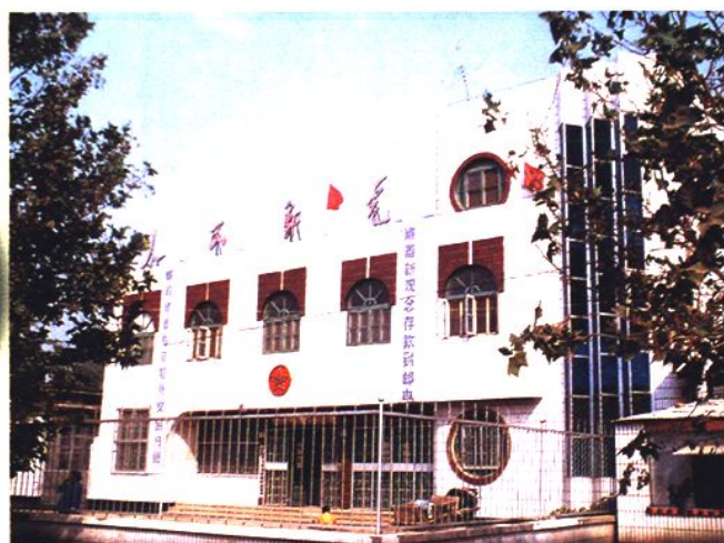
张习桥支局综合通信楼（1995年）
