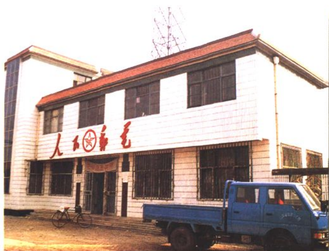
黄集支局综合通信楼 (1995 年)
