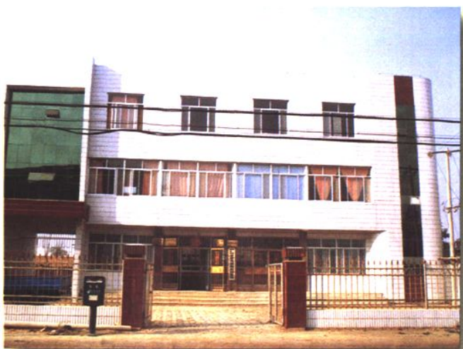
前孙支局综合通信楼 (1997 年)
