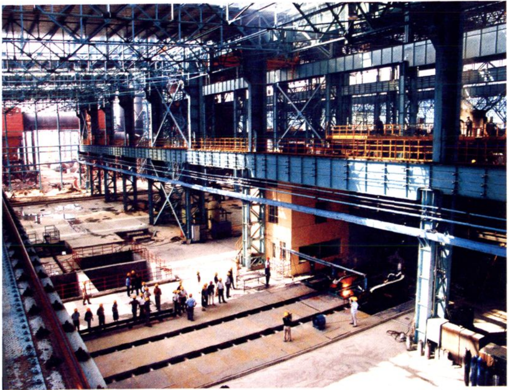
华业特钢不锈钢项目生产现场
