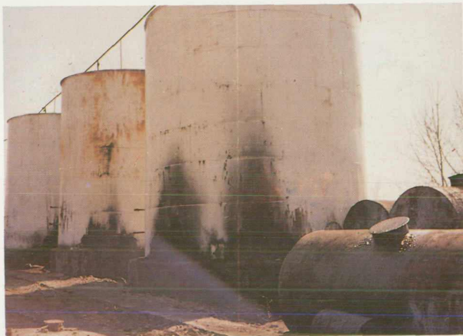
第三粮库油罐
