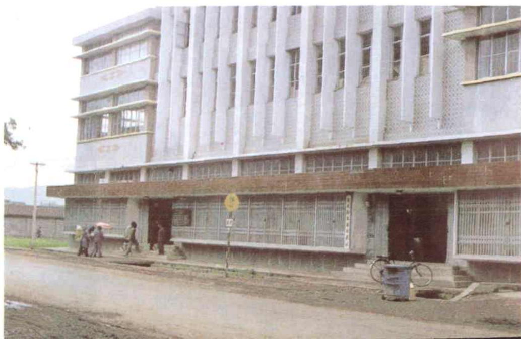
东岭供销社贸易大楼
