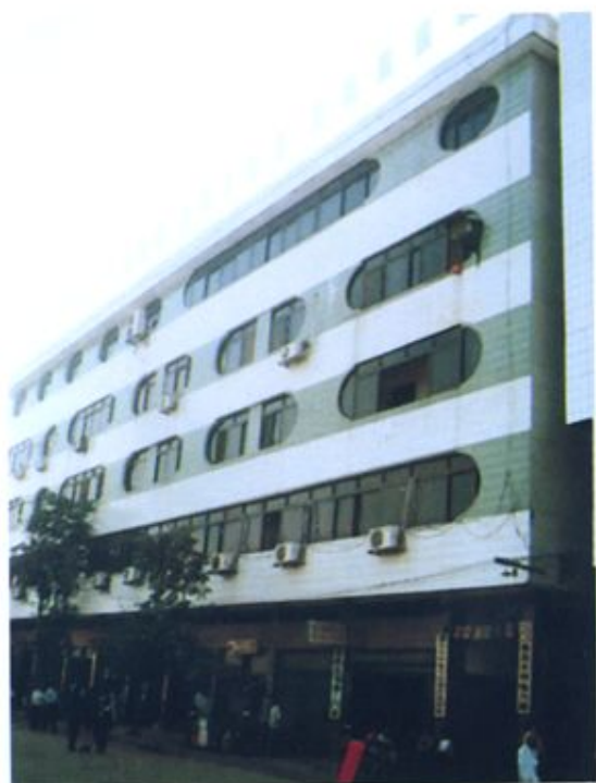
▲藤县水利电力局办公楼
