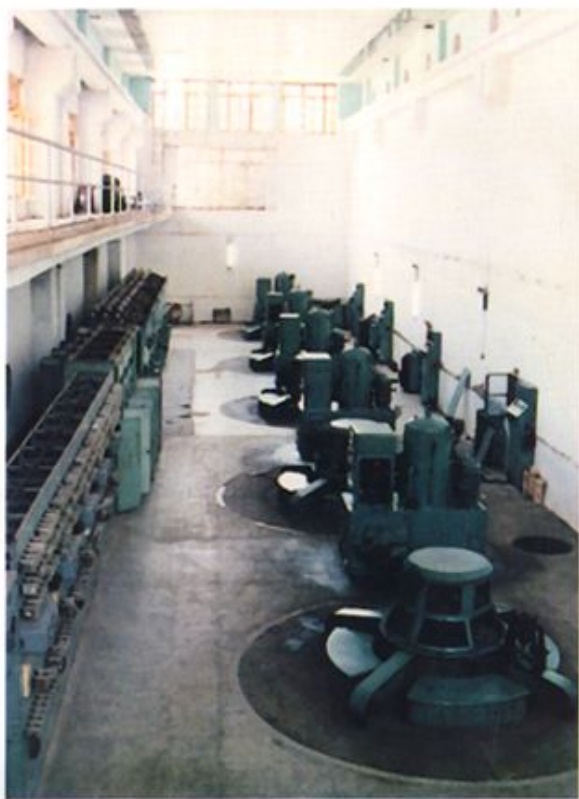
◀交口水电站发电一厂厂房
