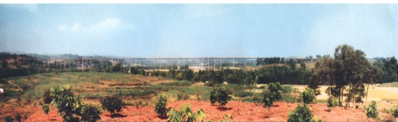
▲留利引水工程柴咀波槽
