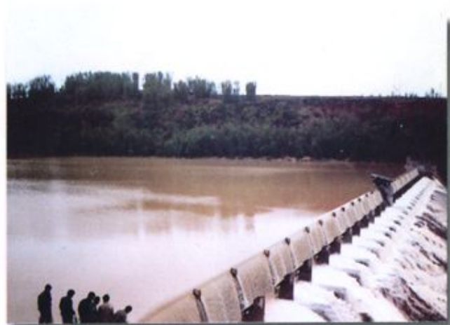
▲交口水电站活动闸坝(原为橡胶坝)
