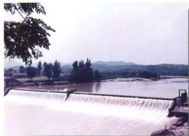
▲交口水电站橡胶坝(现已拆除)
