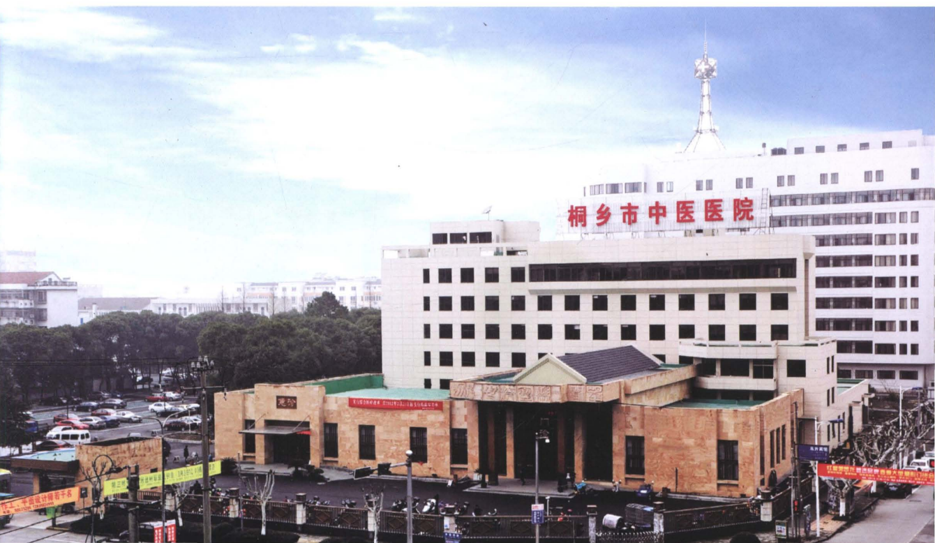
2012年3月，迁至茅盾西路的医院门诊部与住院大楼
