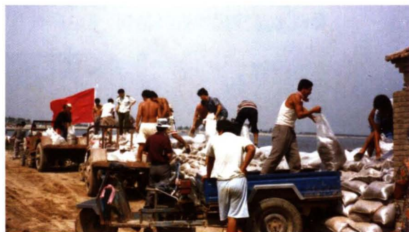
2001年8月1日，东平湖老湖出现高水位并遇8级大风，群众运送料物，在二级湖堤八里湾段抢修子堰
