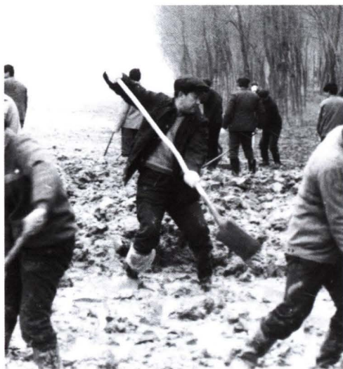
1991年3月12—14日，东平湖管理局局长李金堂（中）和全局干部职工为开挖出湖河道修筑分界围堰
