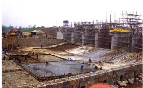
八里湾泄洪闸改建施工现场
