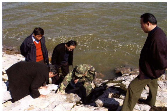
2003年10月15日，东平湖管理局局长司毅民（左二）、泰安市副市长彭华（右一）察看二级湖堤石护坡风浪坍塌险情
