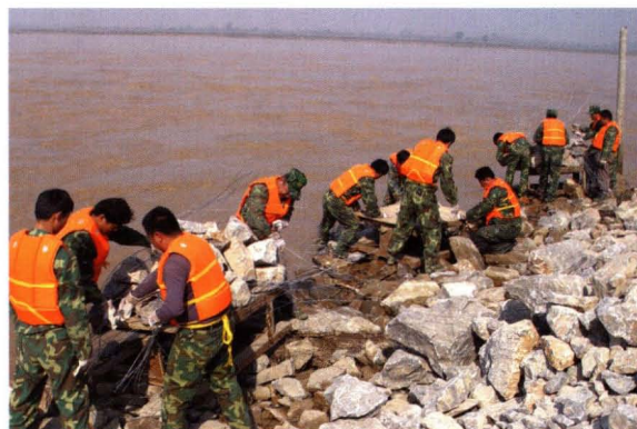
2003年10月18日，东平县黄河肖庄工程7号坝出险，抢险队抛铅丝笼抢护险情
