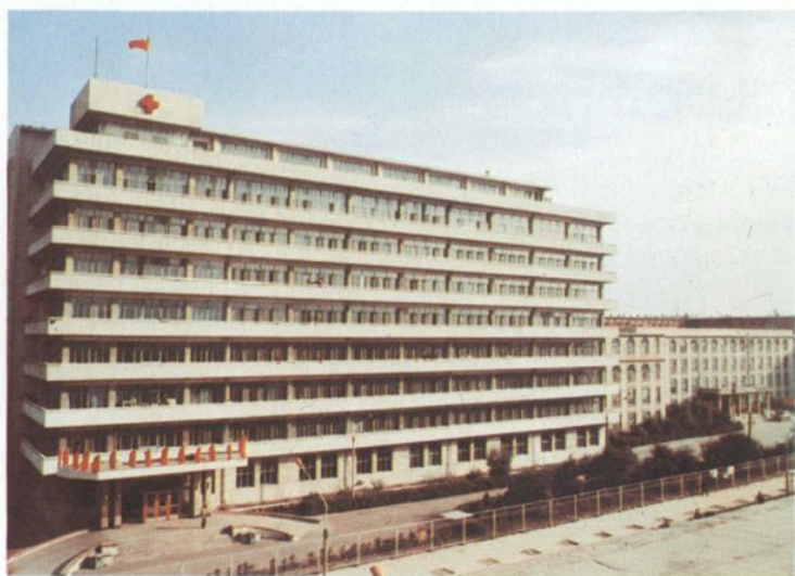
▲ 全国卫生系统先进集体、省文明医院—— 抚顺市第四医院（现市中心医院）病房大楼。
