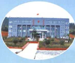
改善了政府农业综合服务大楼整体
