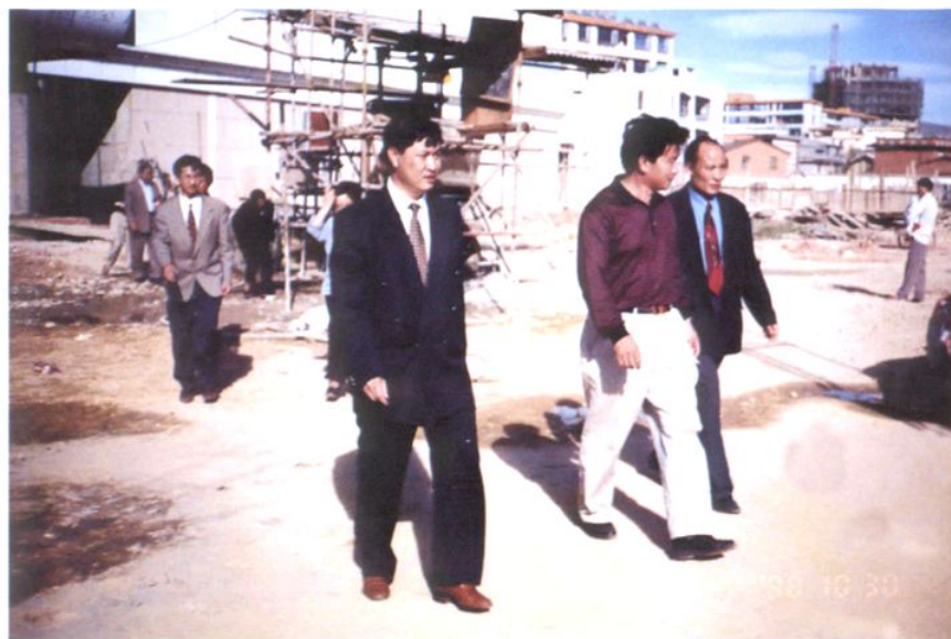
1998年10月30日，州委书记赵仕杰在县委书记卜德诚、县长张万礼陪同下视察禄丰县广电中心工程建设。
