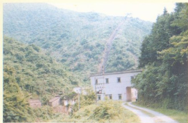
大水坑一级发电站
