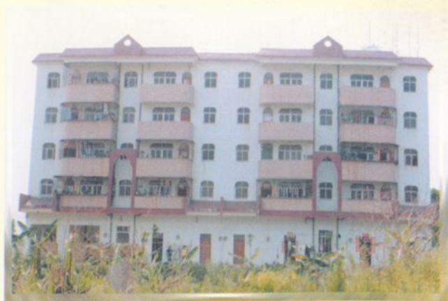
杨梅河小水电管理站职工住宅楼
