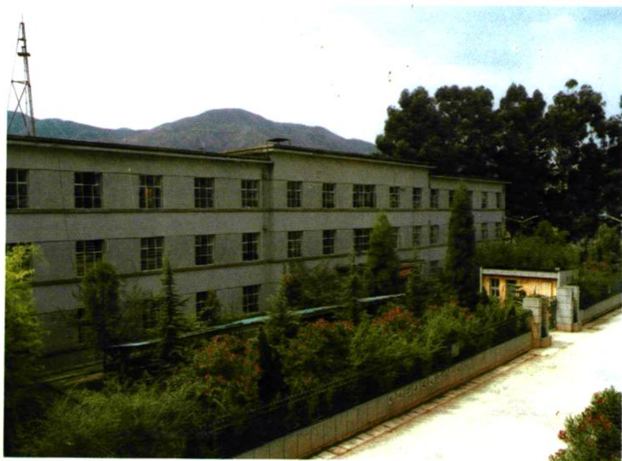
矿行政办公大楼
