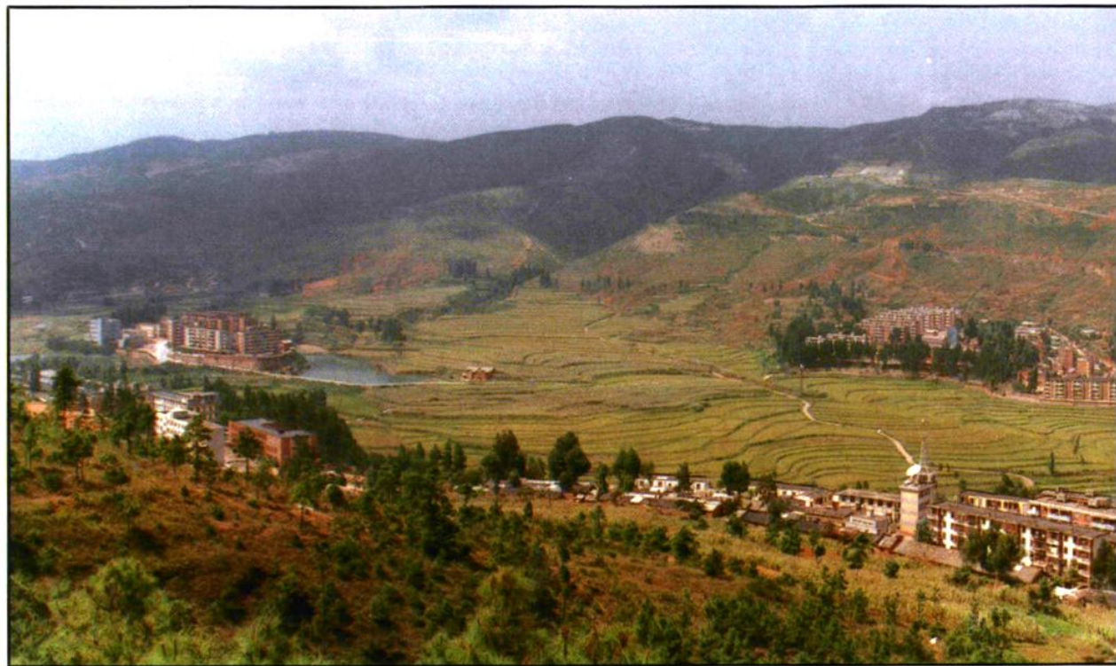
昆阳磷矿区全景
