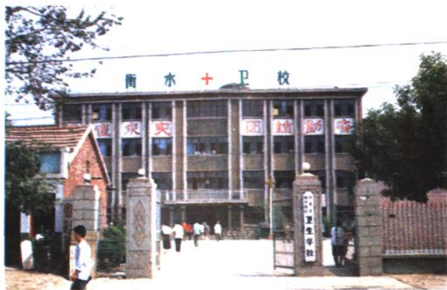
◀衡水地区卫生学校 教学楼
