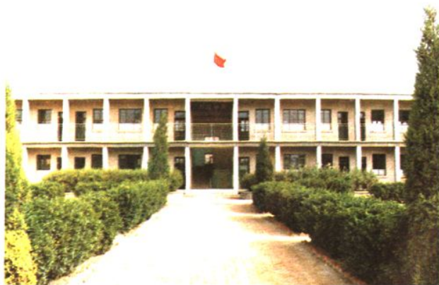
▶衡水市何庄乡马村 小学教学楼。
