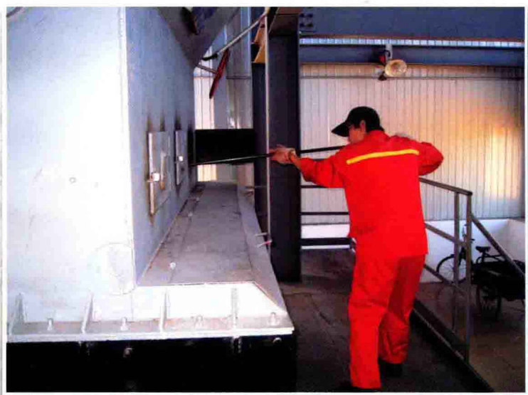
油改煤注汽工程
