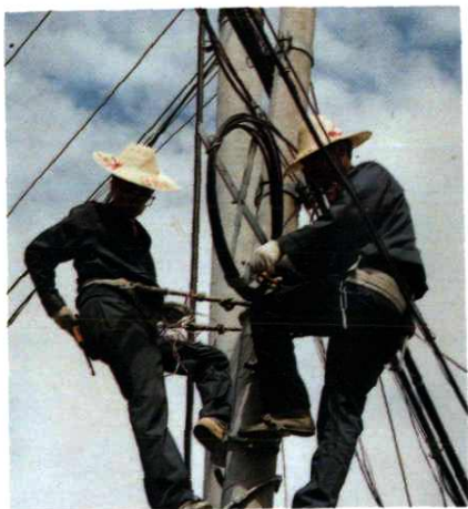
施工人员正在进行光缆线路割接
