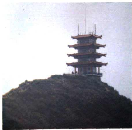
位于绍兴最高点香炉峰上的 无线信号发射机房
