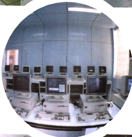
无线寻呼机房
