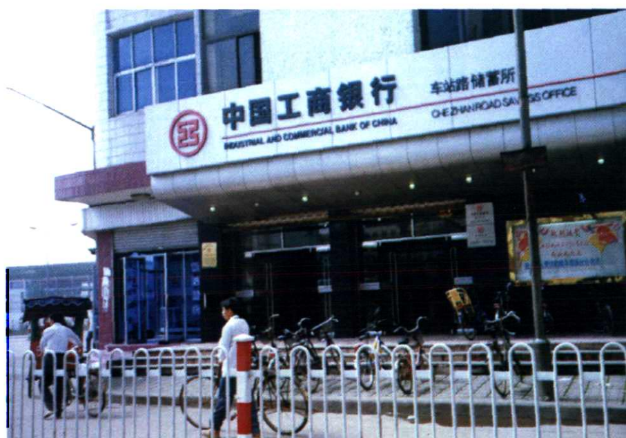
市工行车站路储蓄所
