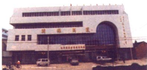
江宁县供销合作总社(原废旧物资回收公司)再生资源总公司的开源商厦。
