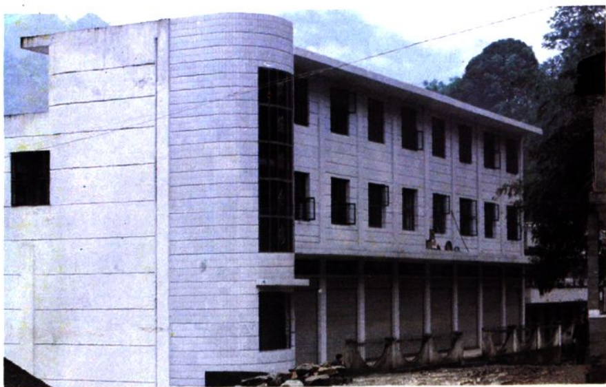
沿河土家族自治县恩渠供销社现在 使用房屋
