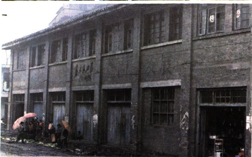
沿河土家族自治县恩渠供销社50年 代所建的营业用房
