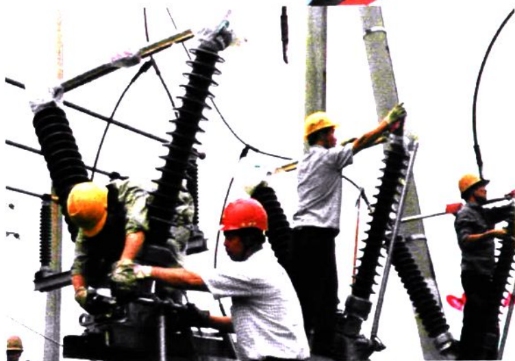
检修工人在变电站检修隔离开关
