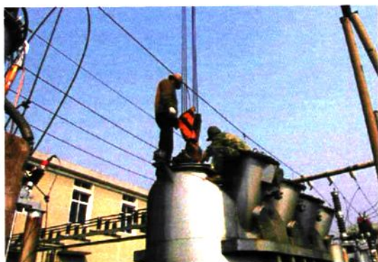
工人们在变电站吊装变压器
