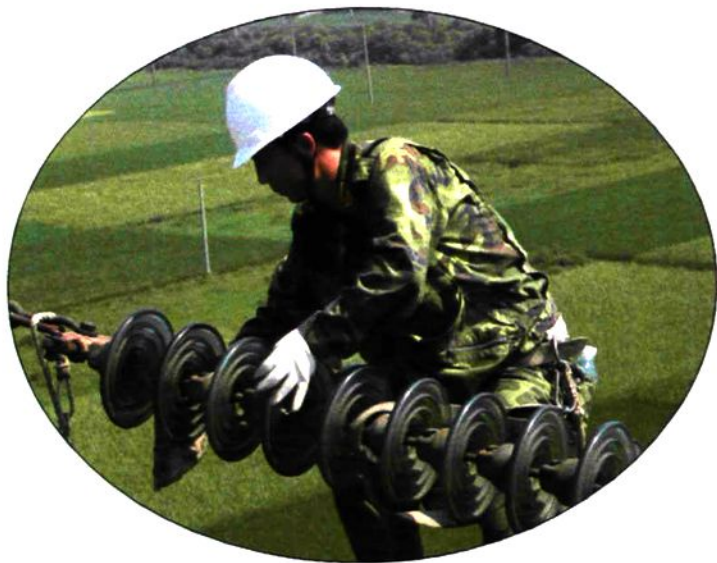
线路工人在输电线路绝缘子串上检修
