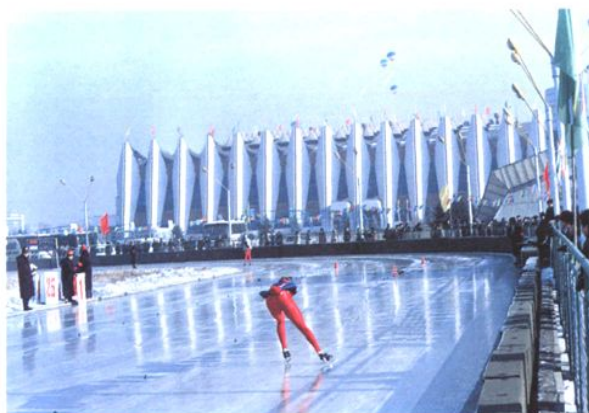
冰上运动中心人工制冷速度滑冰场
