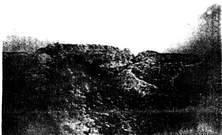
土筑防卸工事遗迹
