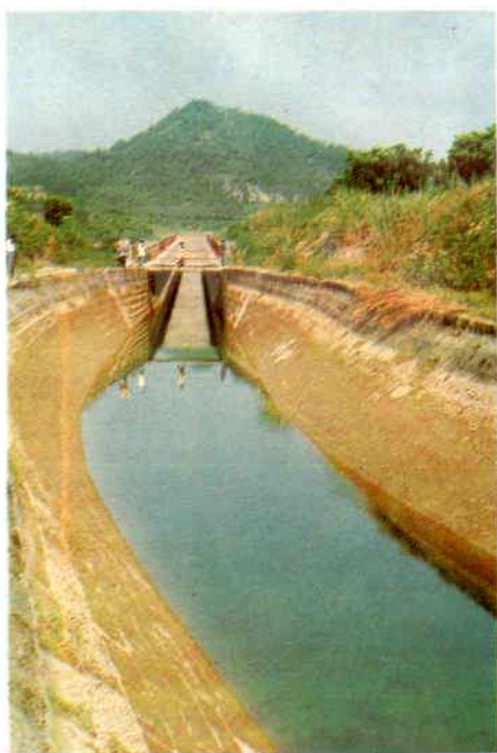
西充干渠吉家坝渡槽
