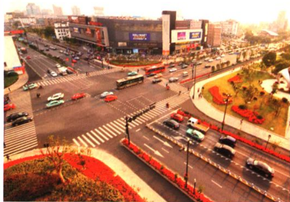
临平邱山大街与藕花洲大街交叉口改造（2010年 总投入 1706万元）
