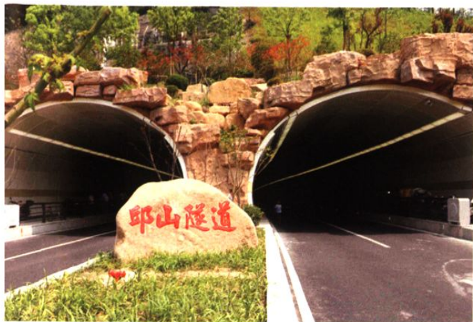
邱山隧道（2010年 总投入1.71亿元）
