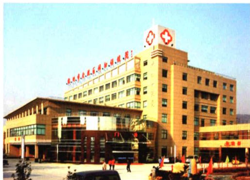
余杭区妇幼保健院（2005年 总投入2917万元）
