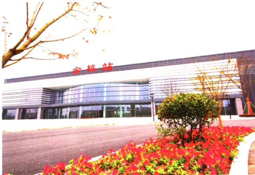
沪杭高铁余杭段、余杭站（2010年 总投入4.55亿元）
